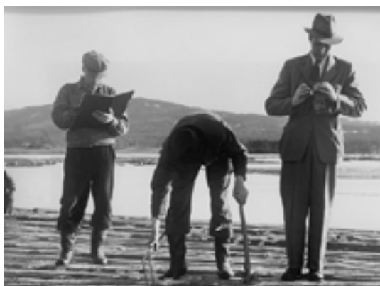
Mätlag i arbete.
